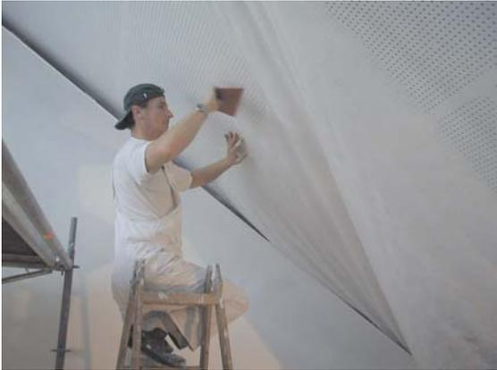
Um eine gute Haftung zu garantieren, werden Untergründe zuerst nach den Verarbeitungsrichtlinien vorbehandelt. Dies beugt ein durchschlagen von Farbveränderungen, Haftungsprobleme, und dergleichen vor.
