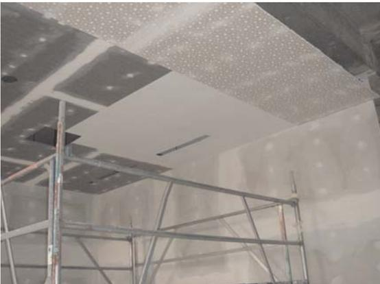
Metawell Aluminiumlochplatten-System mit integrierter Heiz- und Kühlanlage wird mit Akustikvlies überzogen und mit offenporigem, feinem (0,5mm Körnung) Akustikputz beschichtet und zu einer optisch monolithisch geschlossenen Oberfläche verarbeitet.
